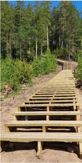
Golfkentän puoleiset portaat rakennusvaiheessa 30.5.2023
