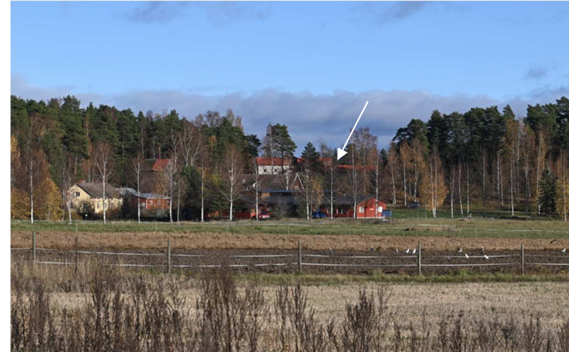
Kuva: Vanhainkodin talouskeskus. Etualalla näkyvä yksikerroksinen punainen rakennus on myöhempiä koulurakennuksia. Mummola osoitettu nuolella.
