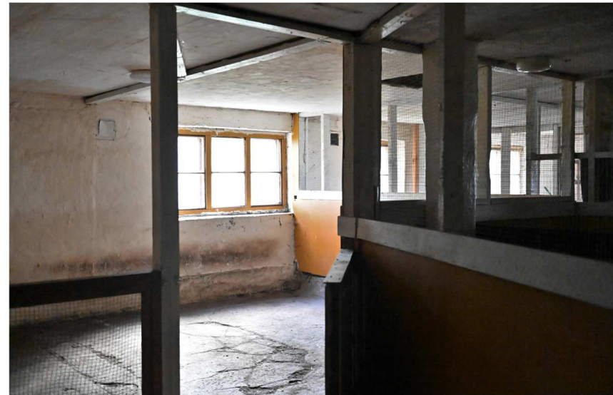
Kuva: Sisäkuva karjarakennuksen alakerrasta, josta on purettu navetan aikaisia rakenteita ja tehty tilalle pilttuita. Raportin s. 3 on kuva ylisiltä.
