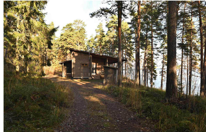
Kuva: Oppilaitoksen rantasauna sijaitsee vanhalla rantasaunalla ja asuntoloiden lähellä sijaitsevalle kodalle vievän rantatien varrella. Rakennuspaikalla sijaitsi aiemmin jätevedenpuhdistamo. Tasannetta on muokattu leikkauksin.
