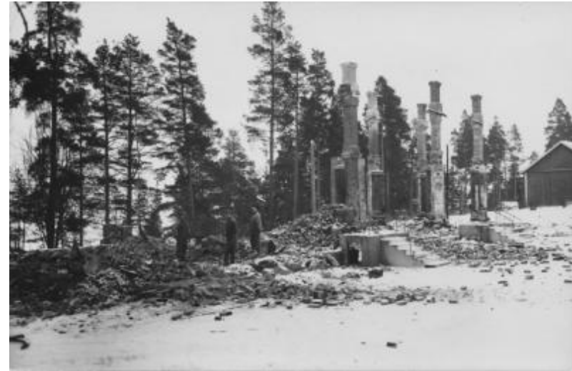
Kuva: Tulopalossa tuhoutuneen kunnalliskodin rauniot. Takana näkyy olemassa oleva puurakenteinen varistorakennus. / Asikkalan kulttuuripalvelut.
