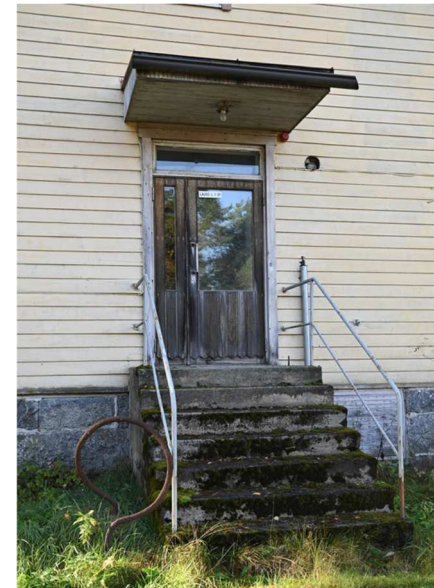
Kuvat: Päätysisäänkäynti on myös 1960-luvun alusta: betoniporras, metalliputkikaide, lippa ja ovi. Sirkkelisahattua lautaa ja alla hirsiseinä.
