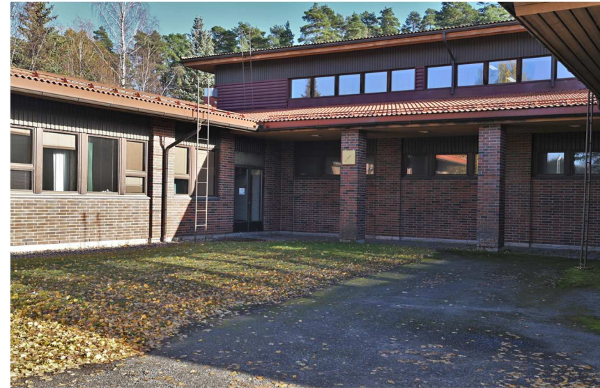
Kuva: Vuonna 1983 valmistunut maatalousoppilaitoksen päärakennus. Korkean keskiosan molemmin puolin on siipien reunustama piha. Länsijulkisivu.
