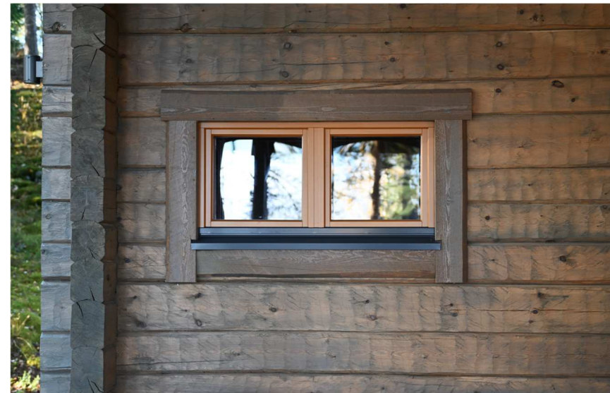
Kuva: Piiluttua hirsiseinää.
