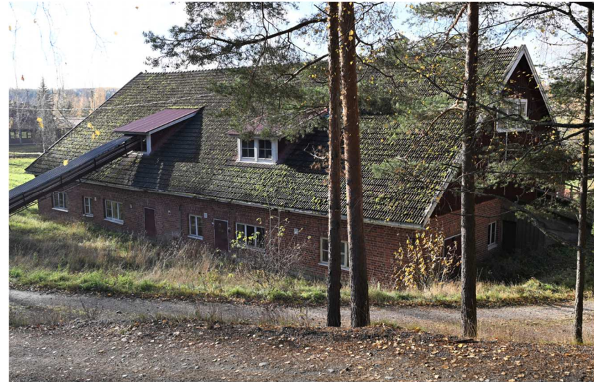
Kuva: Vanhainkodin aikainen käsin lyödyistä tiilistä muurattu karjarakennus.
