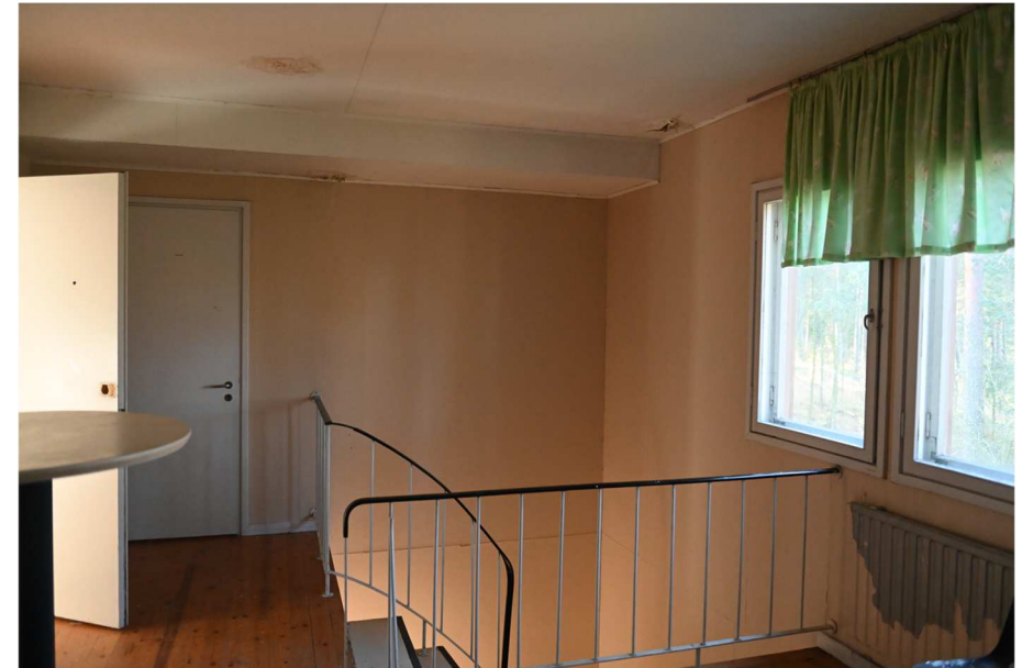
Kuva: Yläkerta on rakennettu 1960-luvun alussa.
