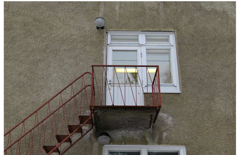
Kuva: Alkuperäinen portaikko ja parveke metalliputkikaiteineen toiseen kerrokseen, jossa on ollut vanhainkodin naisten osasto.
