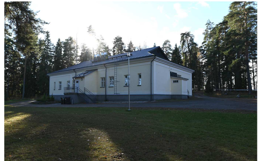
Kuva: Julkisivu itään. Viime remontin yhteydessä puretti katonharjalta aikaisempi poistoilman tuuletuskotelo, myös päätykolmioita on muutettu; alun perin katon päätyviisteet olivat yhtenäiset, ks. ilmakeku s. 18.
